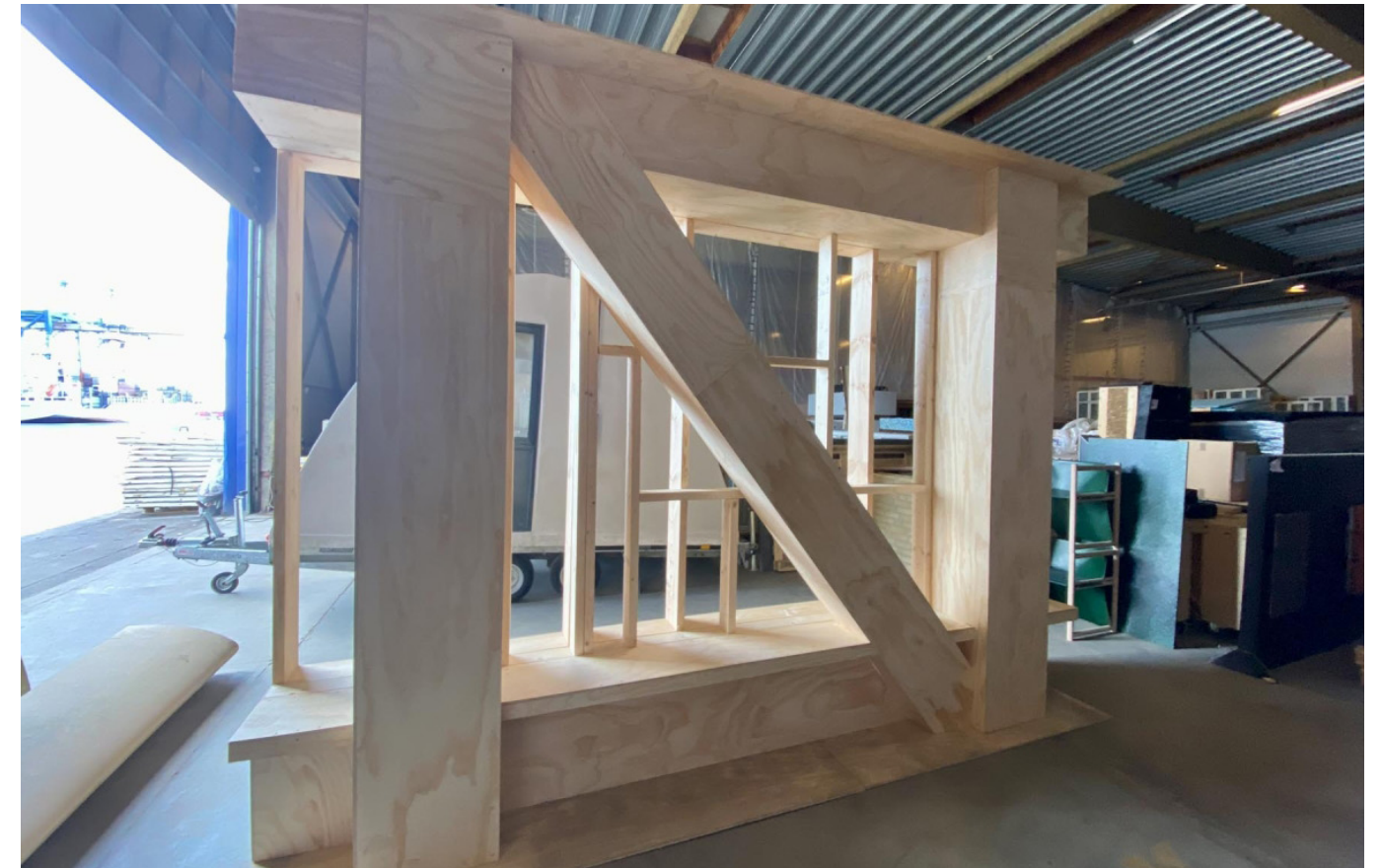
Mock-up af konstruktionen. Foto: Lendager
