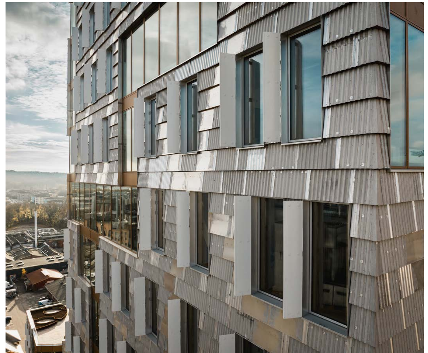
Solafskærmning på facaden. Foto: Anders Nymann Wejse
