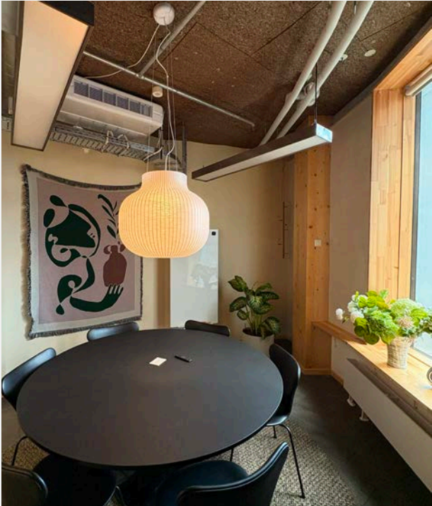
Søuld-plader i loftet og Biomason fliser på gulv
