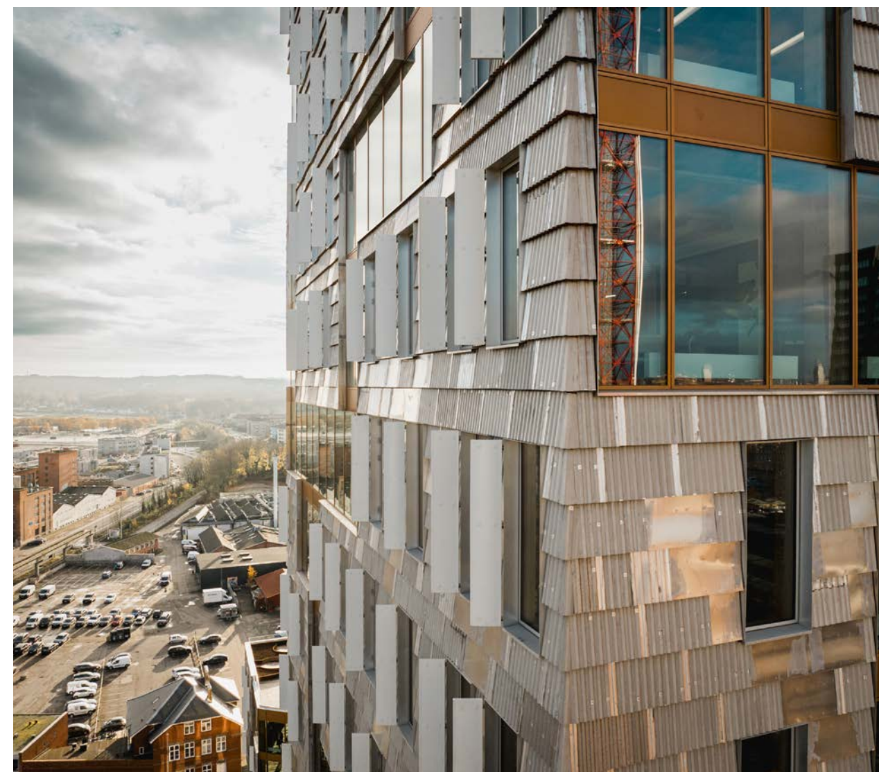
TRÆs facade, foto: Anders Nymann Wejse, Velkendt
